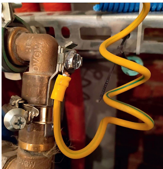
Пример применения червячного хомута с заземлением в сантехнике
