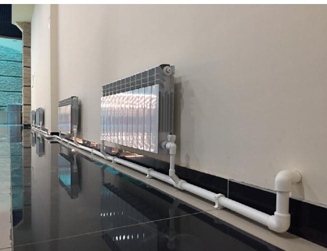
Большинство клипс можно соединять между собой в цепочку – для монтажа нескольких трубопроводов.
