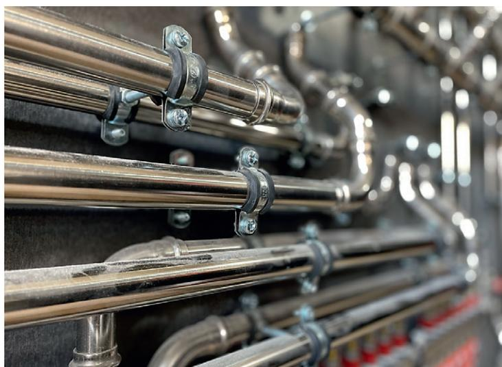
Пример использования стальных хомутов в котельной частного дома в Подмосковье. Обяззка выполнена из нержавеющей труб
