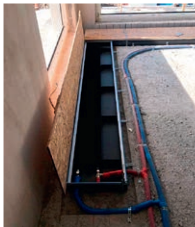
■ Внутripольные конвекторы Jaga Micro Canal (на фото слева) и Jaga Mini Canal Pro (на фото справа)
