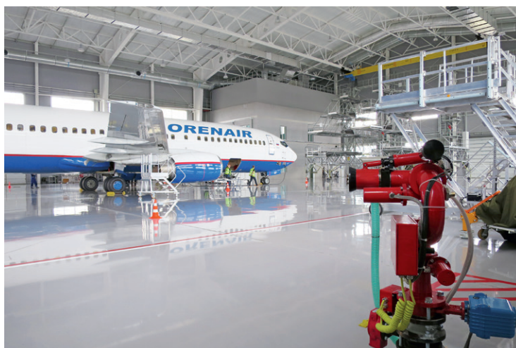
Рис. 3. Пожарные роботы в общепромышленном исполнении установлены в самолетном ангаре (Оренбург)
