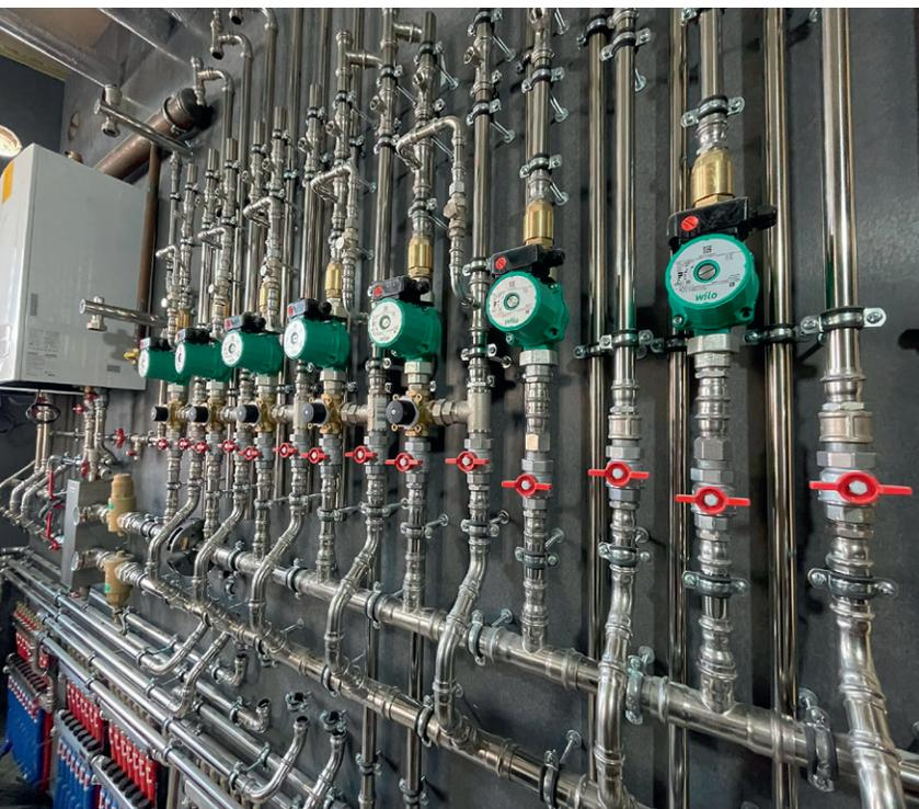
Пример использования стальных хомутов в котельной частного дома в Подмосковье. Обвязка выполнена из нержавеющей труб
