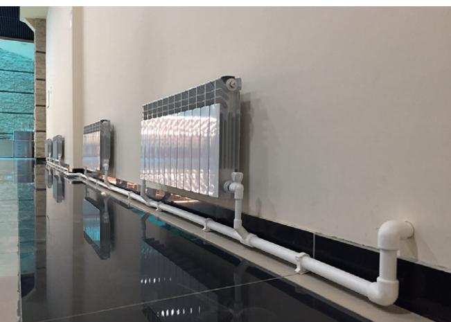
Большинство клипс можно соединять между собой в цепочку – для монтажа нескольких трубопроводов.
