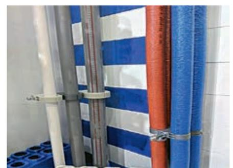
■ Рис. 9. Упорядоченные с помощью пластиковых трубных хомутов трубы в изоляции и без нее
