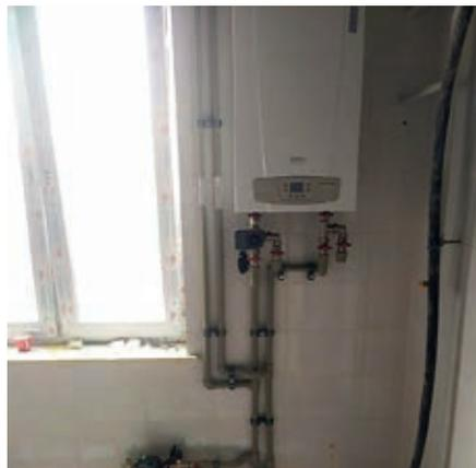
Рис. 11. Разводка труб горячего и холодного водоснабжения у бойлера
