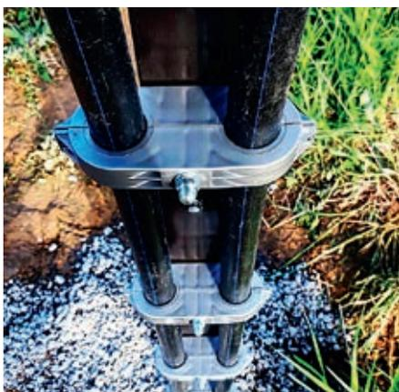
Рис. 14. Крепление подвода кабелей к раздаточной коробке
