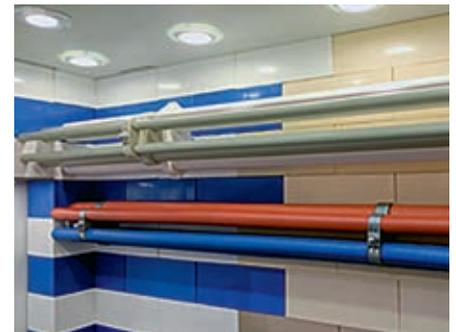
■ Рис. 7. Крепёж труб с двумя типами изоляции: простота монтажа налицо
