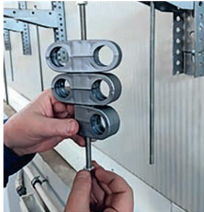
■ Рис. 5. Выравнивание хомута на несущей винтовой шпильке
