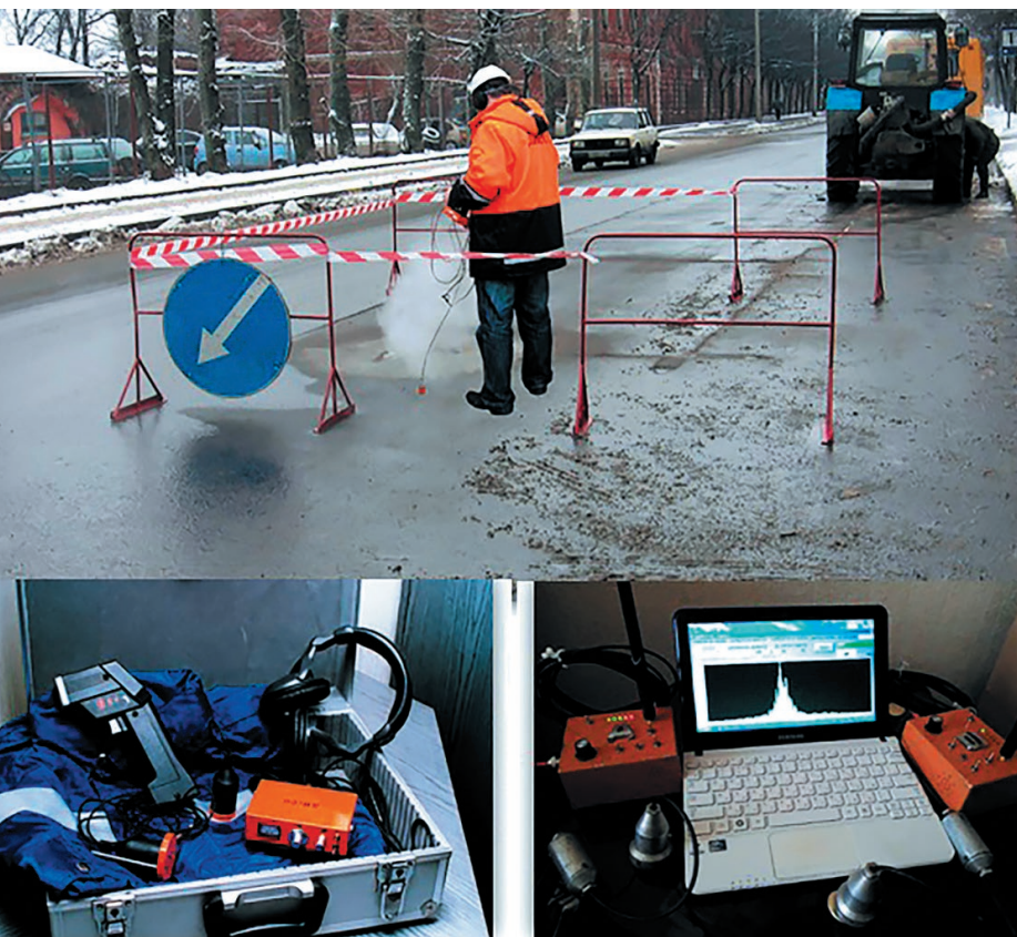
Рис. 4. Наземное обследование аномальных участков методами акустометрии
